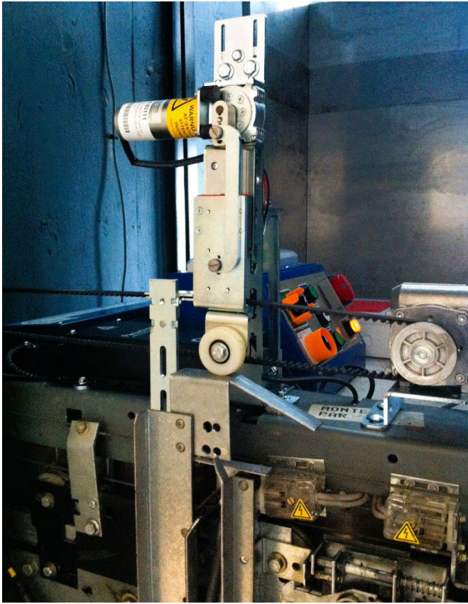
Fig. 8: TSG Sinus Drive en Thyssen M2Z D6
